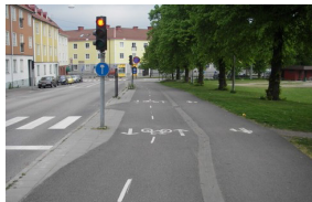
T-KRYSS MED PASSASJE FOR SYKLISTER
