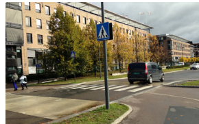
SYKKELOVERGANG MED HUMPER
