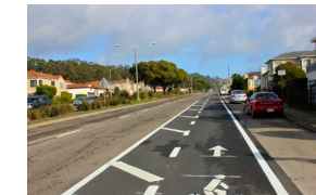
SYKKELFELT INNTIL GATEPARKERING MED SIKKERHETSSONE TIL KJØREFELT FOR BILER
