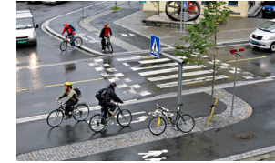
30-SIKRET PASSASJE, HUMPER, VARSELLINJE
